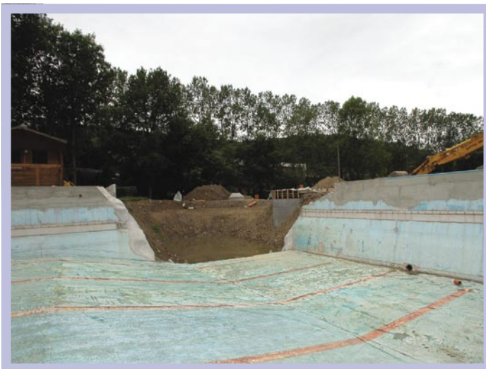
Um den Erlebnisbereich an den Wasserkreislauf im Becken anschließen zu können, musste ein Teil der Außenwand abgebrochen werden.
