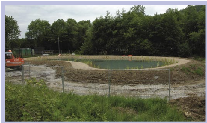
Der fertig bepflanzte und aus verkehrssicherungstechnischen Gründen eingezäunte Aufbereitungsbereich sorgt für klares Wasser im Naturerlebnisbad.
