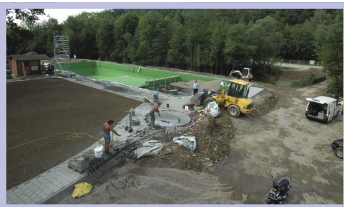
Das Schwimmbecken ist mit Folie ausgekleidet, der Duschplatz fertig gepflastert – das erste Anbaden ist zum Greifen nahe.
