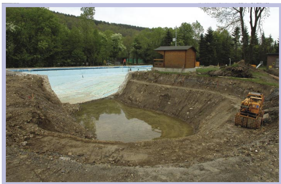
Durch den stabilen Untergrund im Erlebnisbereich konnte dort auf Stützmauern aus Beton verzichtet werden.
