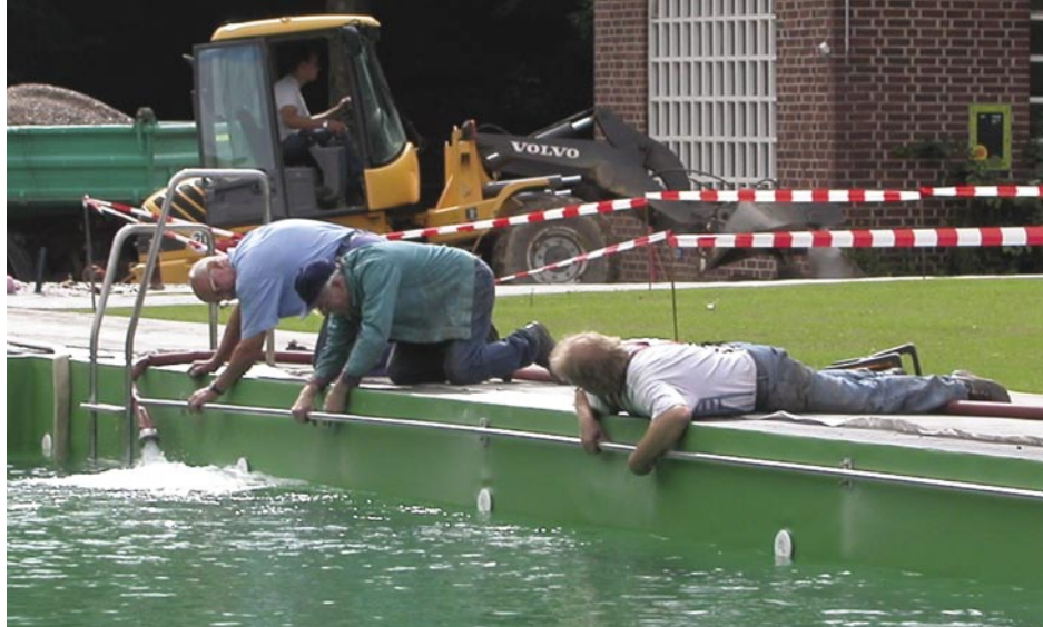
Drei Mann waren nötig, um den gesetzlich vorgeschriebenen Handlauf aus Edelstahl am Beckenrand zu montieren.
