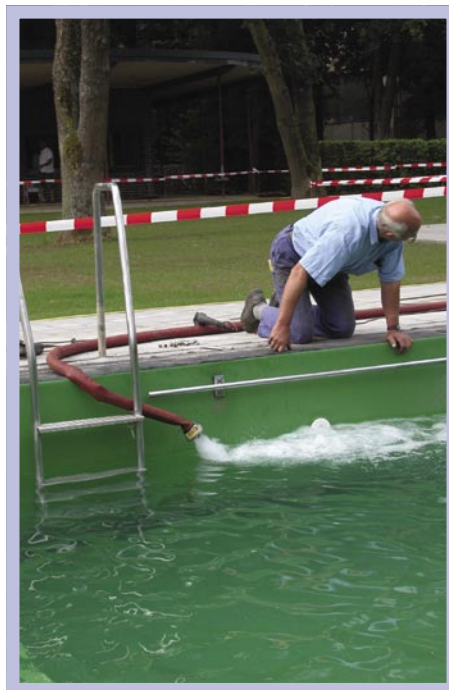
Keine Zeit verschenken: Während der Befüllung montierten ehrenamtliche Helfer unter anderem die Handläufe am Beckenrand.
