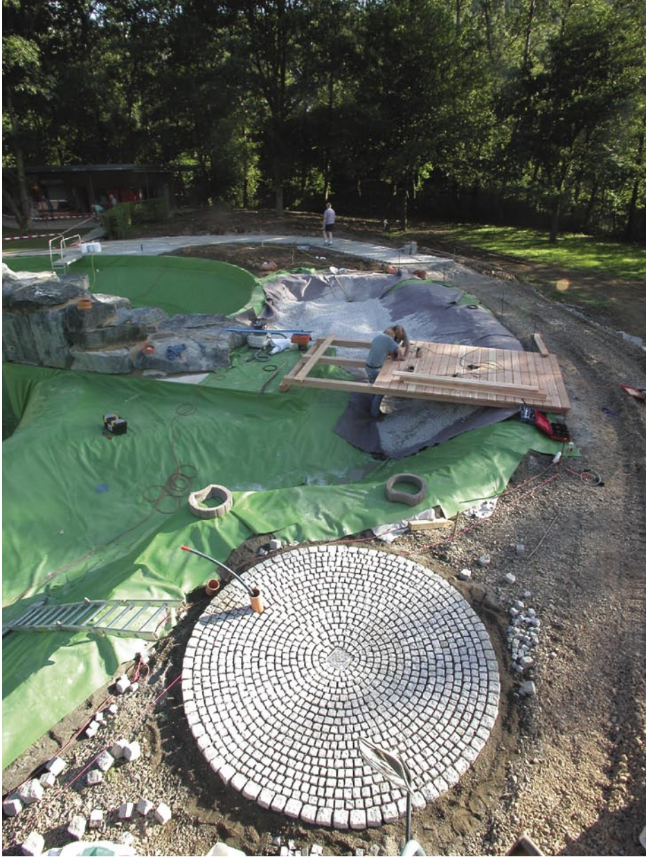
Der großzügige Duschplatz erhält eine rutschfeste Pflasterung aus Natursteinen. Der Steg wurde – ebenso wie die restlichen Außenanlagen – in Eigenleistung erstellt.
